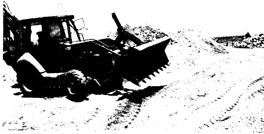
Acarreo Interno, material procedente de excavaciones (01.05.04).
