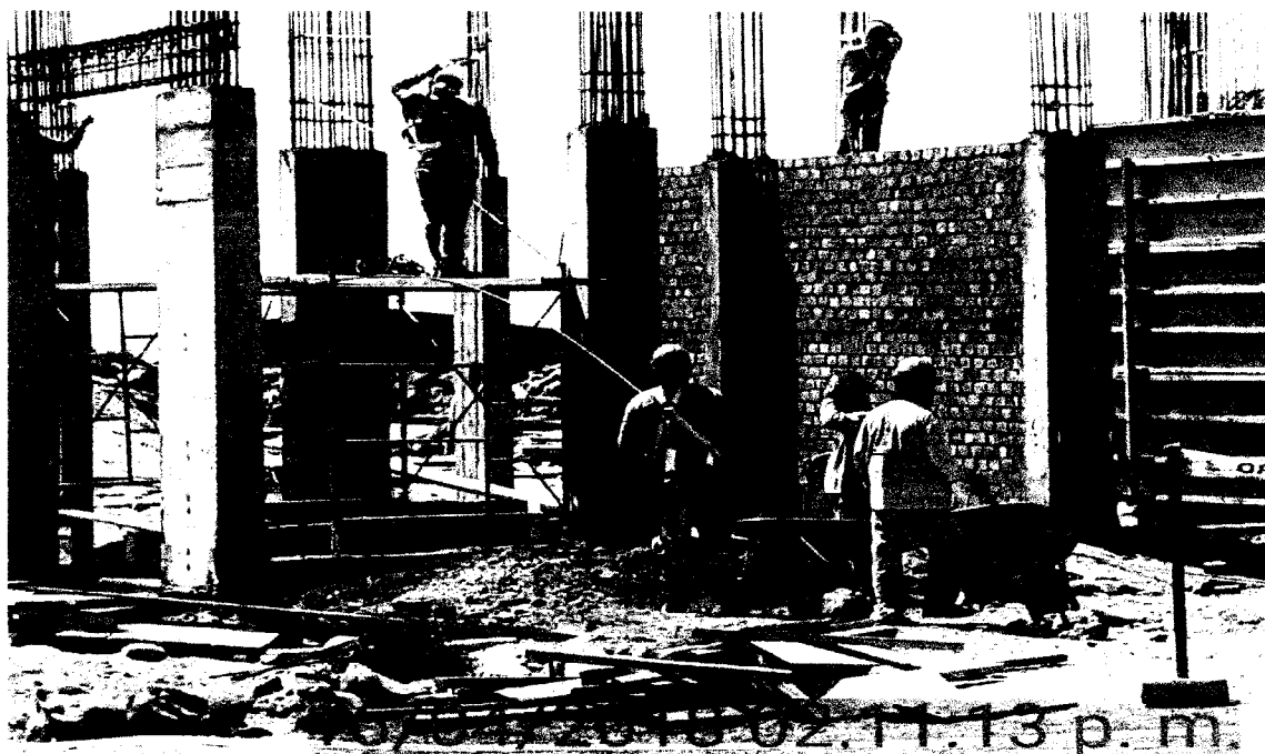
Imagen N°9: A la vista de la imagen se aprecia a los trabajadores realizando trabajos de desencofrado de las columnas, con sus andamios, arnés de Seguridad, instalados en su Línea de vida cumpliendo con las Normas de Seguridad.
