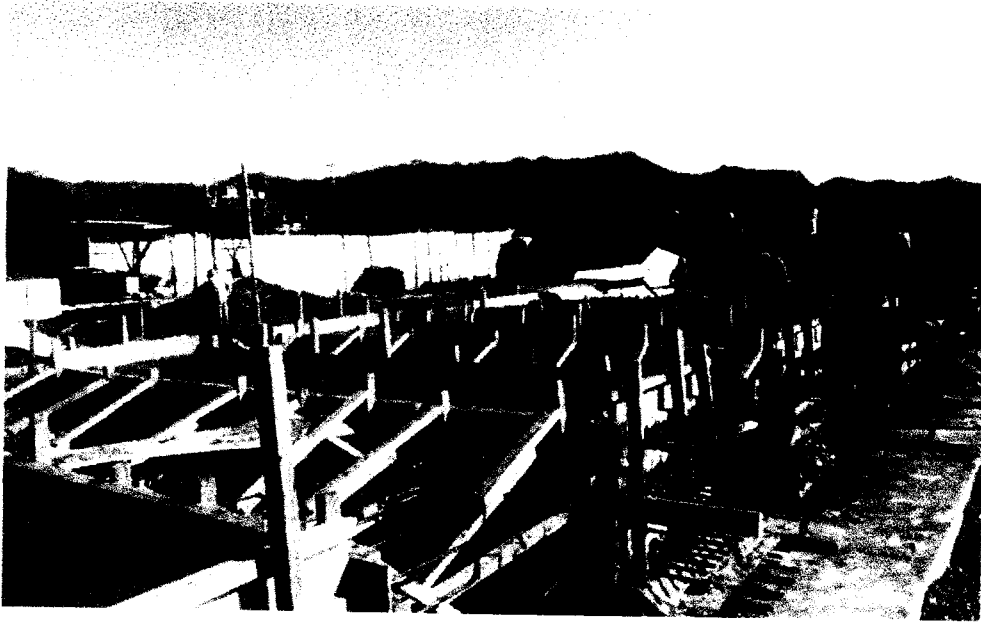
Encofrado y Desencofrado normal (05.05.02)
