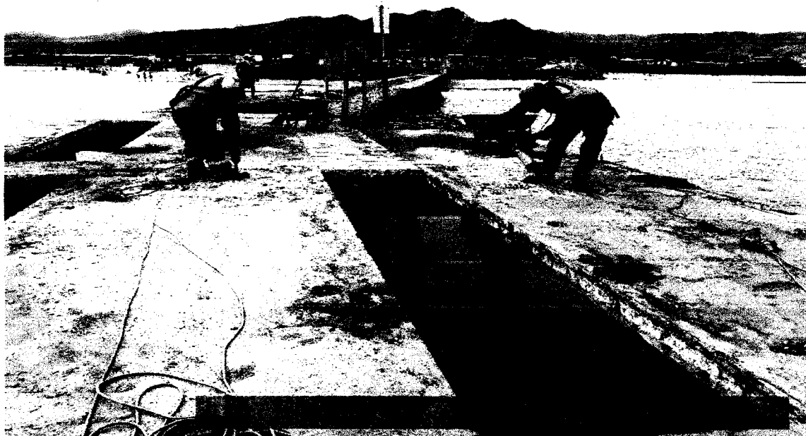
Imagen N°2: A la vista de la imagen se aprecia a los trabajadores correctamente usando sus EPP's, realizando trabajos de demolición en el cabezo del muelle Acapulco
