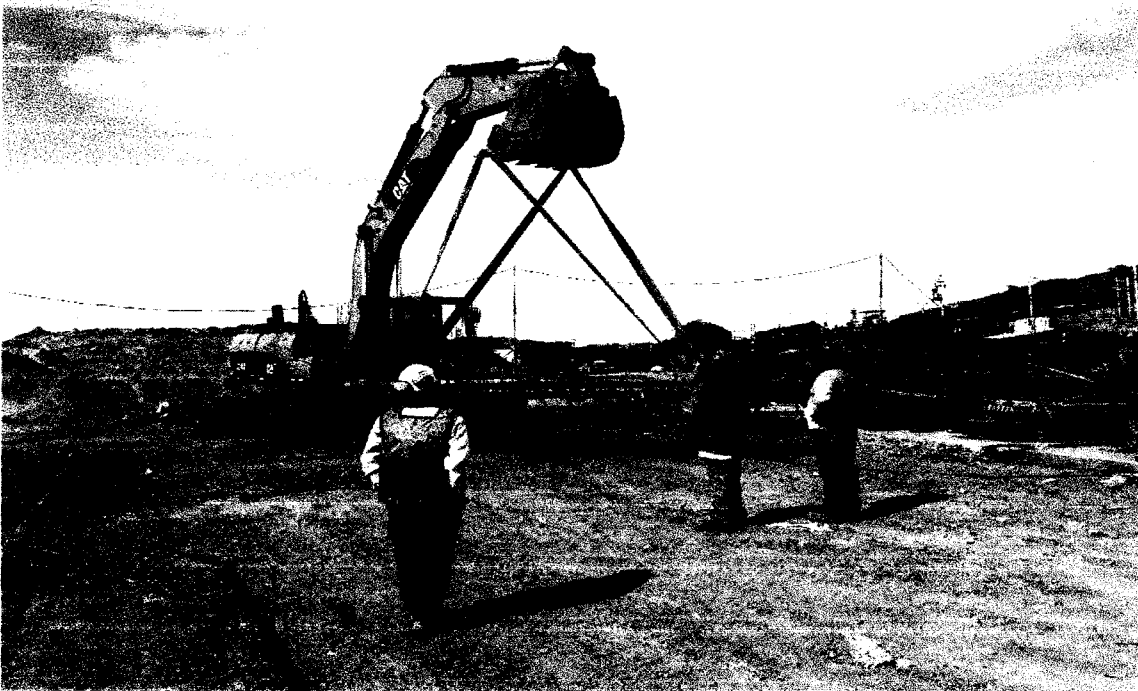
Imagen N°19: A la vista de la imagen se aprecia al Jefe SSOMA Ricardo Misahuamán C. Realizando una inspección de las eslingas para el trabajo de izaje con el apoyo de excavadora tipo oruga CAT-324D LME que se está realizando en la obra DPA- Acapulco
