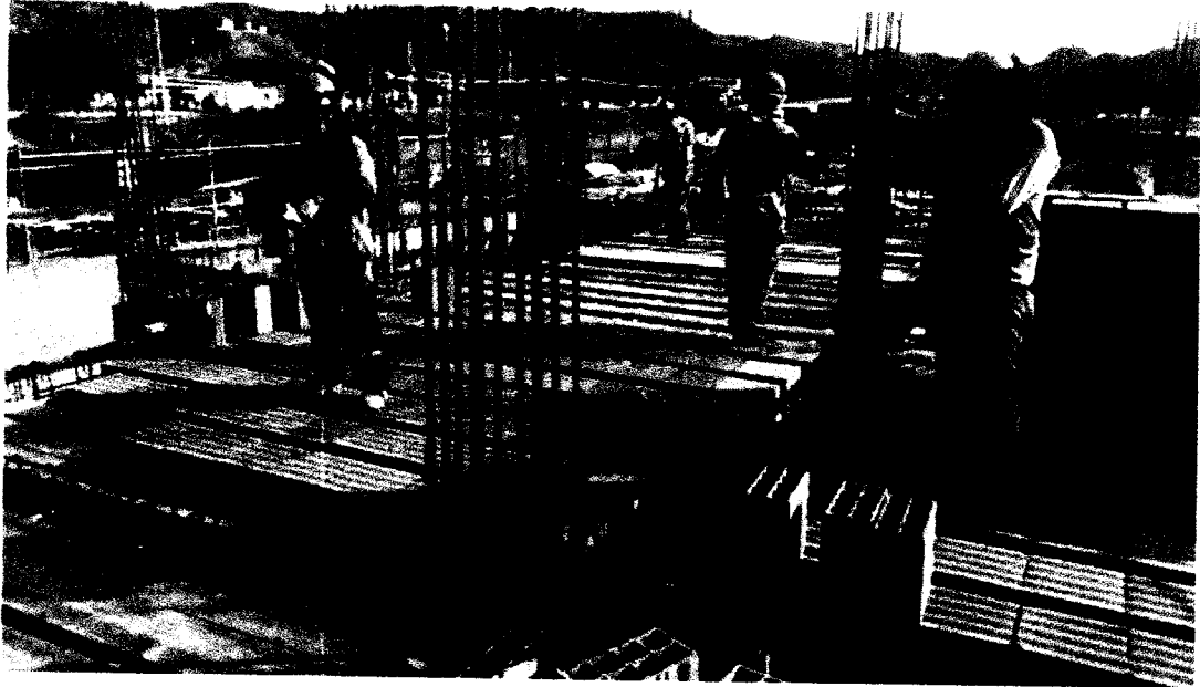
Losa aligerada, ladrillo hueco 15x30x30 (01.07.07.04)
