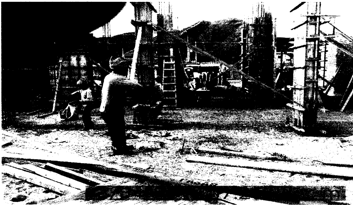
Imagen N°7: A la vista de la imagen se aprecia a los trabajadores realizando trabajos de encofrado de las columnas, con sus EPP's completos para cumplir con las Normas de Seguridad Salud.
