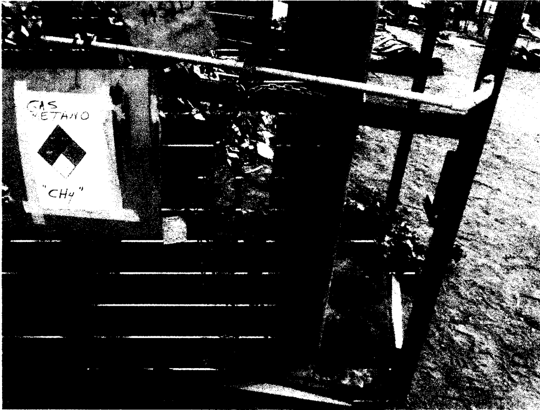
Imagen N°3: A la vista de la imagen se aprecia que el Gas Metano está retulado con el rombo NFPA y MSDS
